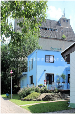
Blick zur Pension und zum Speicher
